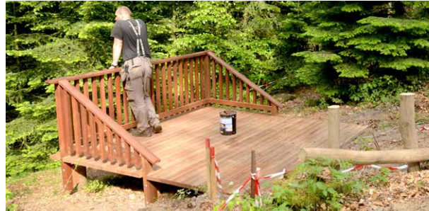
Montering af børnetalerstol ved Himmelbjerget – værn om lystfiskeplatform kunne laves tilsvarende.
